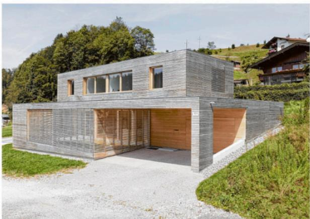
Der Baukörper ist außen zur Gänze horizontal mit sägeraunen bzw. glatt gehobelten Latten aus Weißtanne verschalt.
