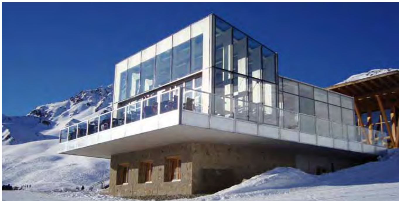
Holzbau Saurer – Masner Bar in Serfaus: „Ein Bergkristall, der sich bewegt. Geschützt und geborgen bei Kälte und Schnee. Offen, wenn die Sonne scheint.“ Die im Jahr 2008 erbaute Holzkonstruktion besticht mit einem besonderen Detail: Hier kann man den vorderen Teil in die Bar verschieben, um die sonnigen Tage besser genießen zu können. Architekturbüro: DI Armin Walch, Reutte
