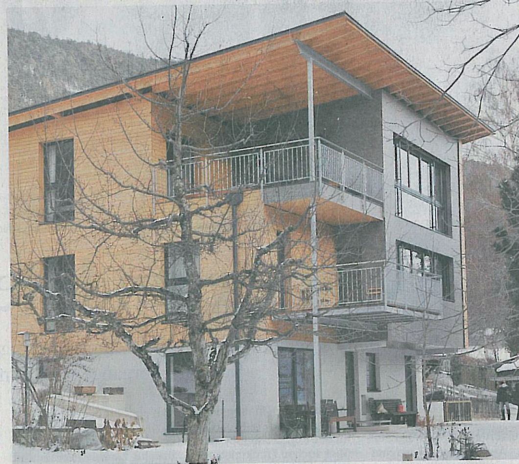
Nachher: ein um das Dachgeschoß aufgestocktes Niedrigenergiehaus mit Pultdach und Lärchenholzschalung.
