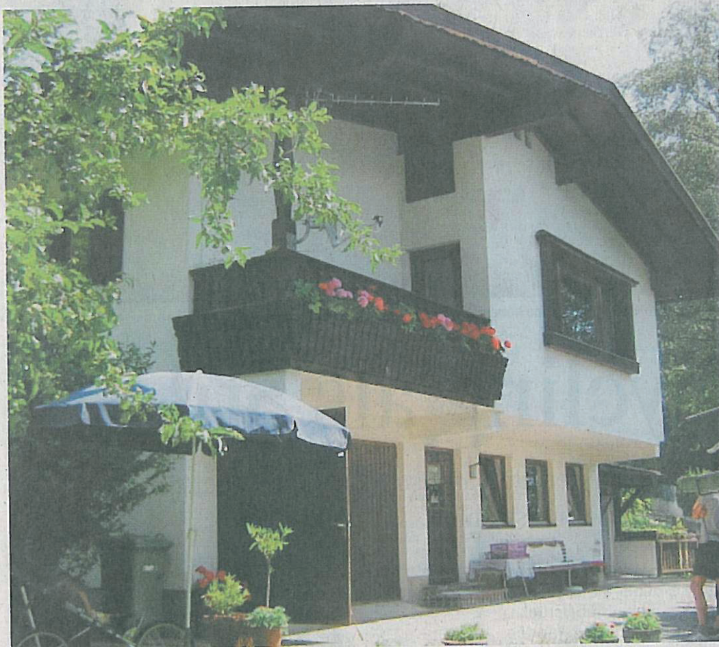
Vorher: ein gemauertes ungedämmtes Haus mit Satteldach und Holzbalkon.
