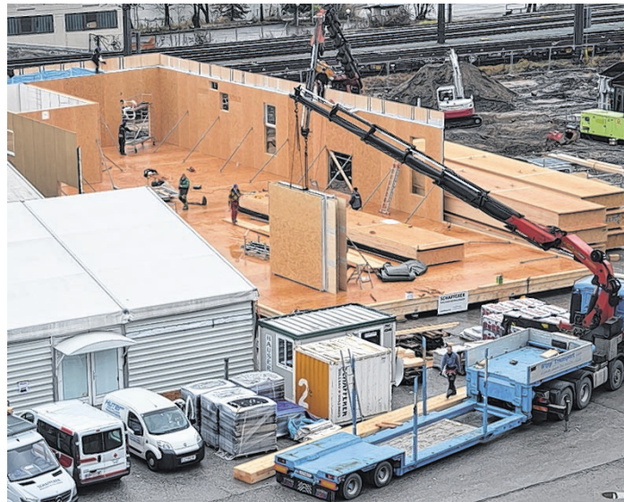
Beim Flüchtlingscamp in Kufstein werden laufend die in Navis vorgefertigten Holzelemente angeliefert und vor Ort von einem Montagetrupp miteinander verschraubt. Polier Michael Glatzl (Bild rechts) gibt letzte Anweisungen.
