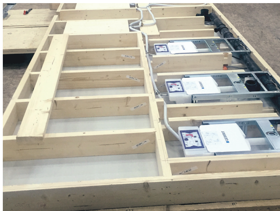
Detail aus der Vorfertigung: Sämtliche Installationen bis hin zu den WC-Spülkästen (im Bild) werden schon im Werk eingebaut.
