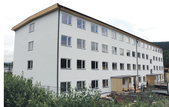
Auch in Innsbruck wurde auf dem Glockenhofareal in Wilten ein Flüchtlingsheim in kompletter Holzbauweise in kürzester Zeit errichtet.
