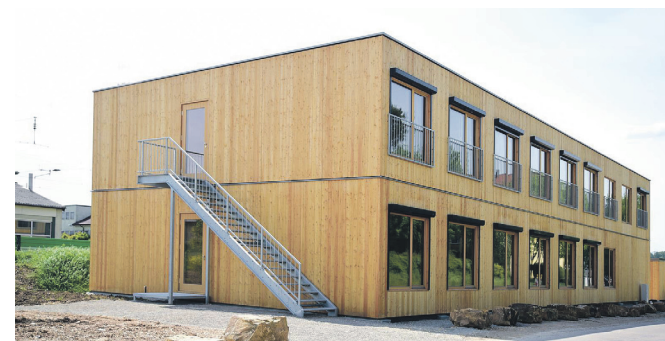
Das fertige zweigeschoßige Gebäude.
