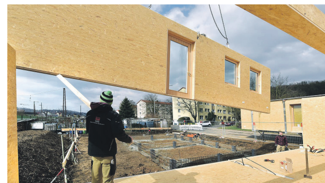
Die vorgefertigten Elemente werden montiert.
