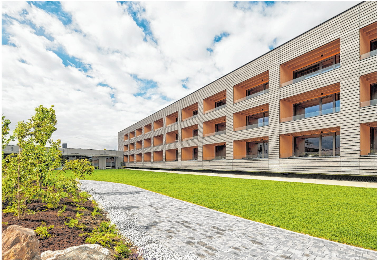
Der Reschenhof wurde um einen Gebäudetrakt großzügig erweitert, der in nachhaltiger und energiebewusster Holzbauweise entstanden ist.
