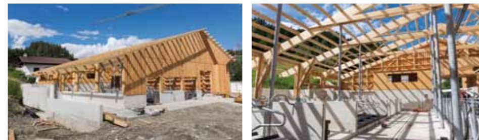
Mutters: Dieser reine Kaltstall wurde als Riegelkonstruktion mit sägerauer Lärchenfassade errichtet. Das verwendete Holz stammt aus dem eigenen Wald des Bauherrn.
