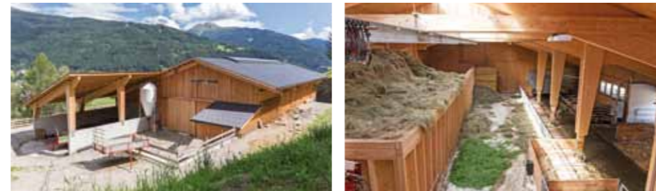
Obfeldes: Dieses Gebäude mit Stall und Heulager wurde gedämmt, innen mit OSB Platten ausgestattet und außen mit unbehandelter Lärche verkleidet.
