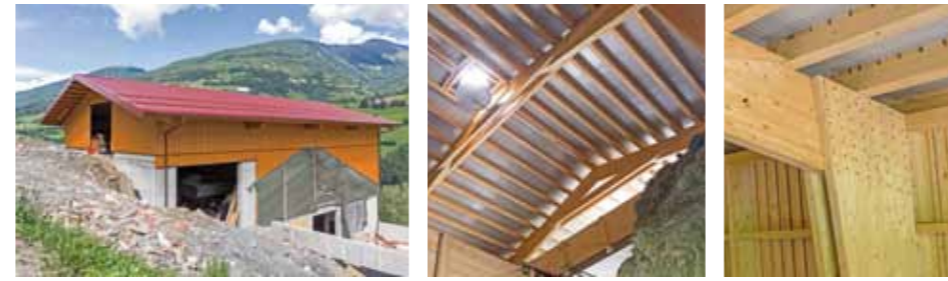
Matreiwald: Die Holz-Riegelkonstruktion mit gestrichener Fassadenschalung ist wärmegeklämt und wurde innen mit 3-Schichtplatten verkleidet.
