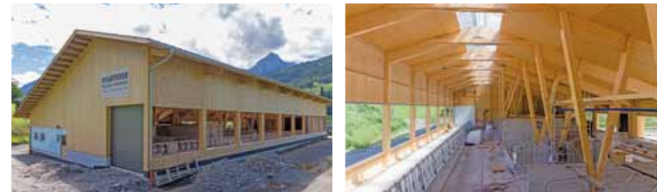
Pfnos: Ein Massivholz-Stall ist eine Besonderheit. Das hochwertige Gebäude wurde innen und außen auf Sicht gebaut und strahlt so die Qualität des Materials auf den ersten Blick aus.
