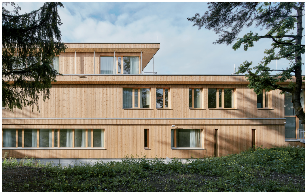
Die Palliativstation, das Mobile Palliativteam, das neue Tageshospiz, die hospiz.palliativ.akademie und die ehrenamtliche Begleitung werden im Hospizhaus Tirol gut vernetzt zusammenarbeiten. Foto: David Schreyer
