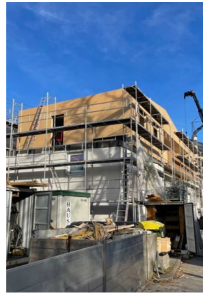
Fotos: Schafferer Holzbau
