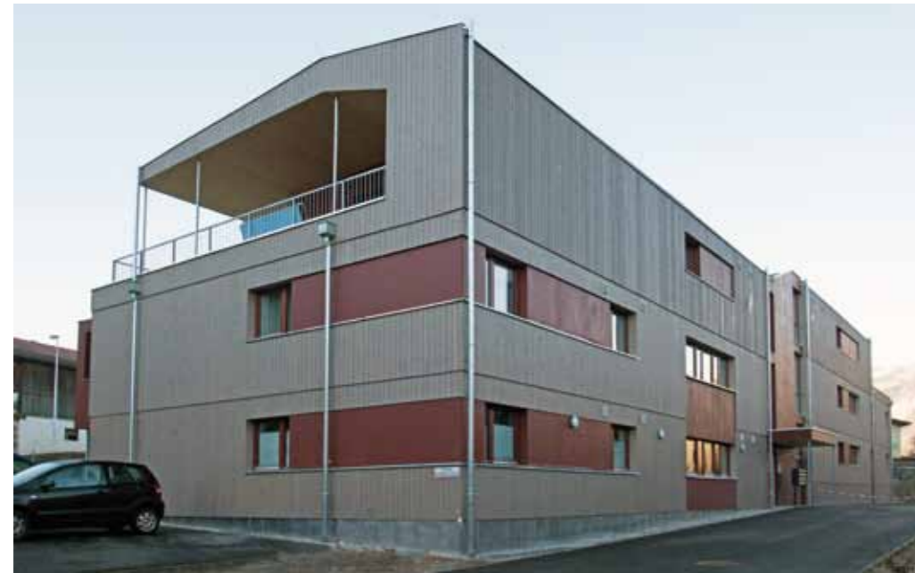
Die Holzfassade – gehalten in Fichte und behandelt mit Holzlasur - verleiht der Wohnanlage ein peppiges Gesicht.
