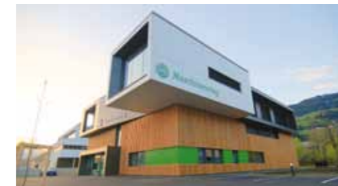
Das neue Maschinenringgebäude in Mils versprüht optischen Charme: Das Erdgeschoß wurde in Massiv-, der erste Stock in Holzbauweise errichtet.
