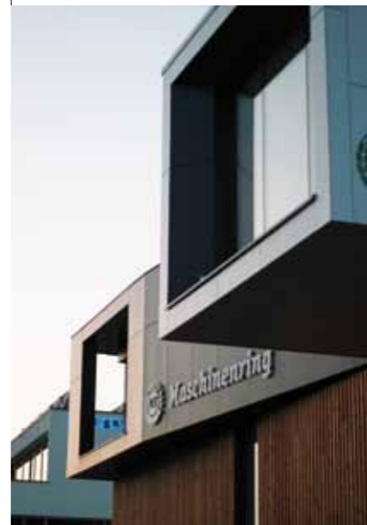
Das neue Maschinenringgebäude in Mils versprüht optischen Charme: Das Erdgeschoß wurde in Massiv-, der erste Stock in Holzbauweise errichtet.
